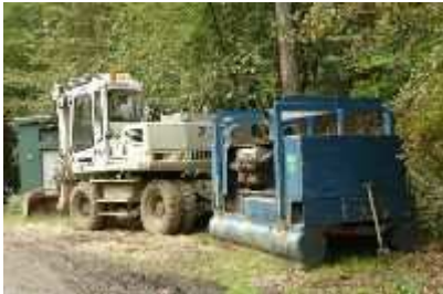
Mit schwerem Gerät durchs Naturschutzgebiet – so nicht, sagt der Kreis und verhängte einen Baustopp. (Foto: Jürgen Venn)
